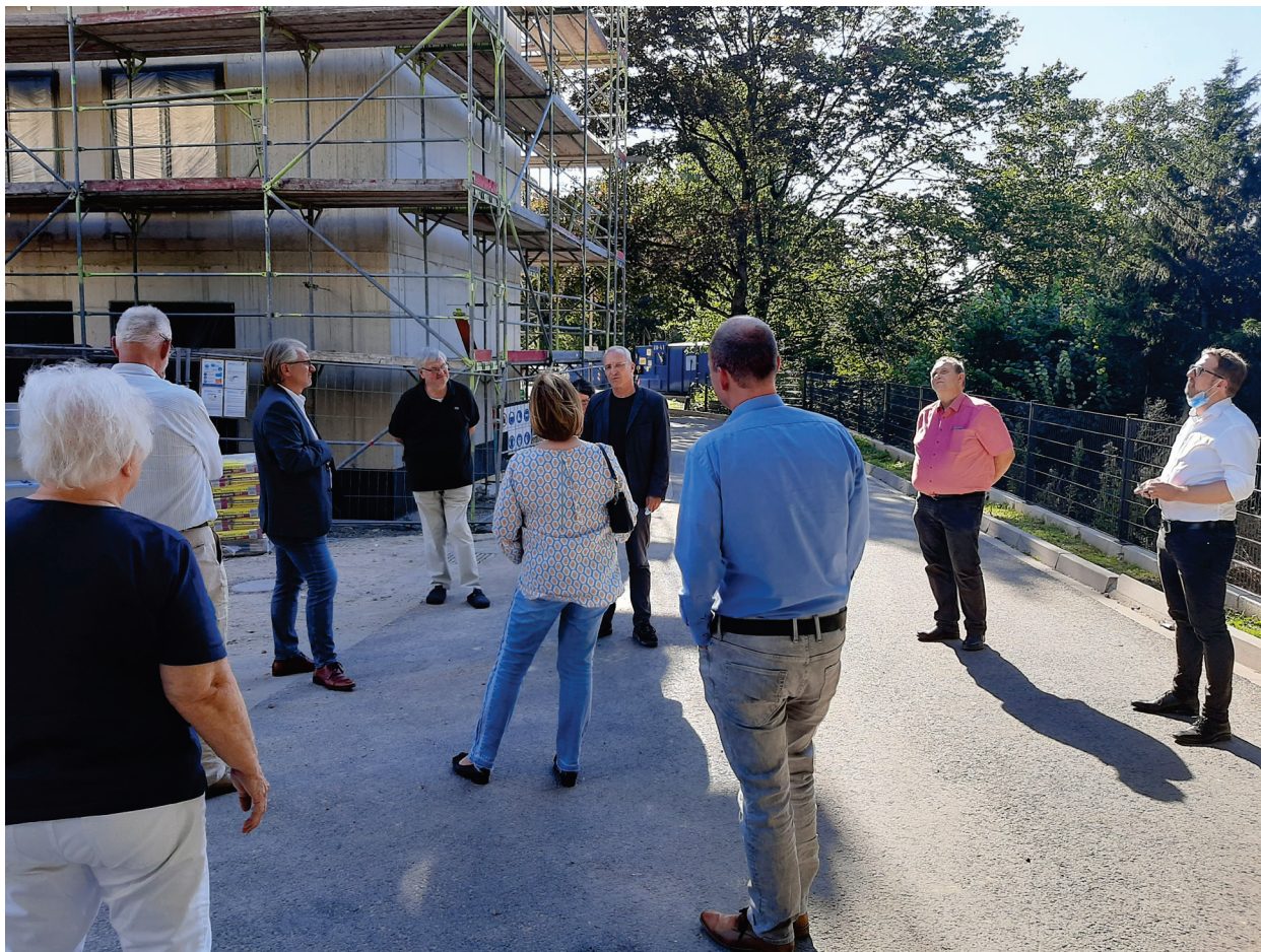
(CDU-Fraktion „vor Ort“ mit dem OB-Kandidaten Marc Buchholz: Diesmal an der Großbaustelle am Seniorenheim Gracht)
